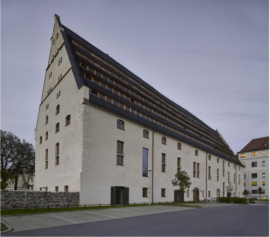
Obr. 10 Městská knihovna ve Zwickau sídlí v impozantní budově středověké městské sýpky (zdroj: https://at2-architektur-tragwerk.de/projekte )
