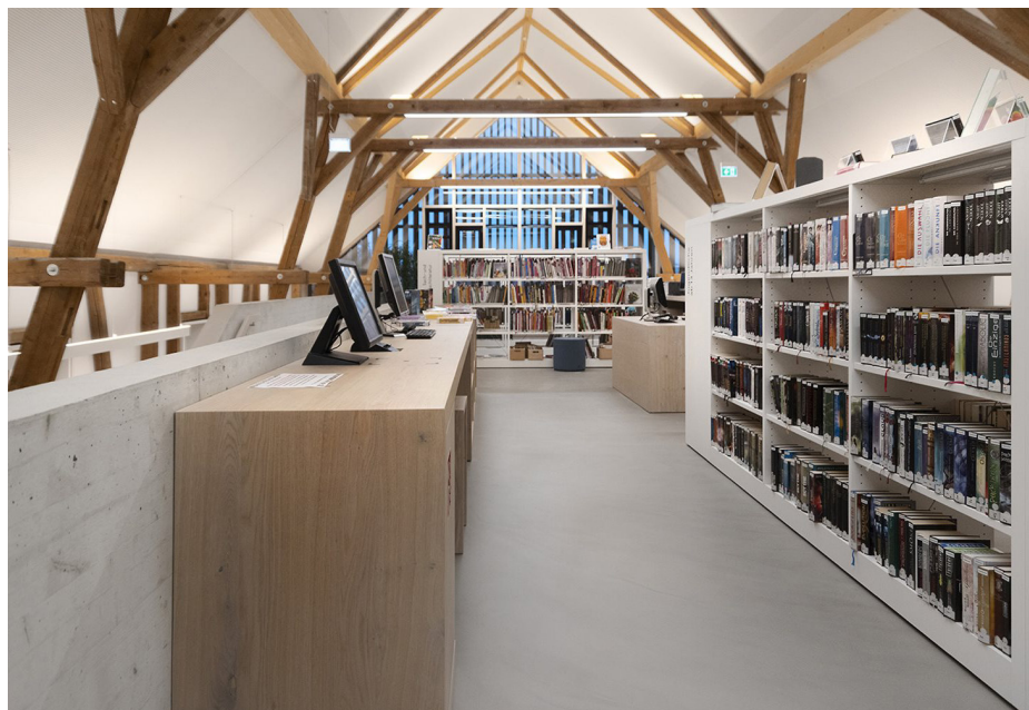
Obr. 6 Interiér s druhotně využitou konstrukcí historického krovu (zdroj: https://afasiaarchzine.com/2019/02/steimle-architekten/ )
