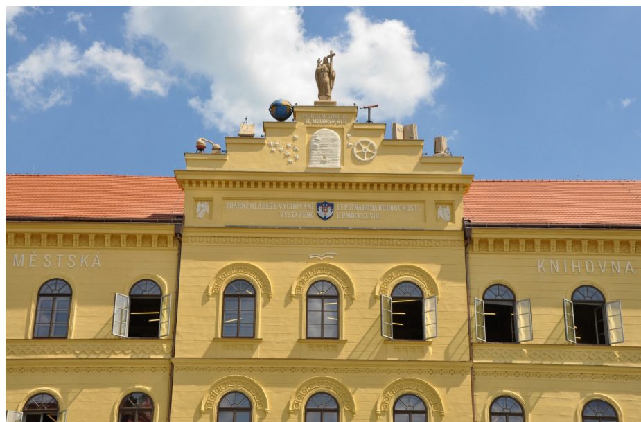
Obr. 1 Čelní fasáda s atributy vědění
